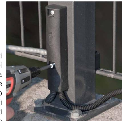
La posa in opera dei sensori **TORSUS 50** consiste nel forare il palo di sostegno della recinzione (Fig. 1), nell'avvitare saldamente il sensore al palo (Fig. 2) e nel coprire le viti di fissaggio con i tappini forniti in dotazione (Fig. 3). Il cavo di collegamento si può fissare direttamente alla struttura per mezzo delle fascette autobloccanti FPM-186 (Fig. 4) oppure si può inserire in un'apposita canalina per esterno.
