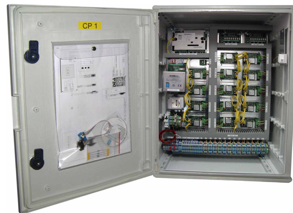
Tipica configurazione di un armadio di centralizzazione SISMA CA
