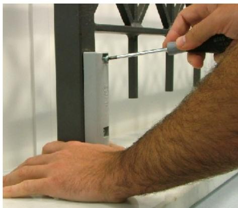
4) Avvitare saldamente il sensore al palo e utilizzare le fascette per tenere fermo il cavo sulla struttura. Indicativamente in misura di 1 fascetta ogni 20-30 cm.
