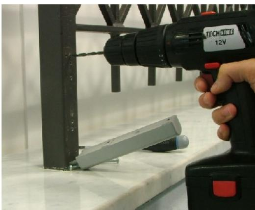
1) sensore dovrà essere posizionato sul palo di sostegno della struttura nel punto di massima torsione (determinato da un test preliminare).
